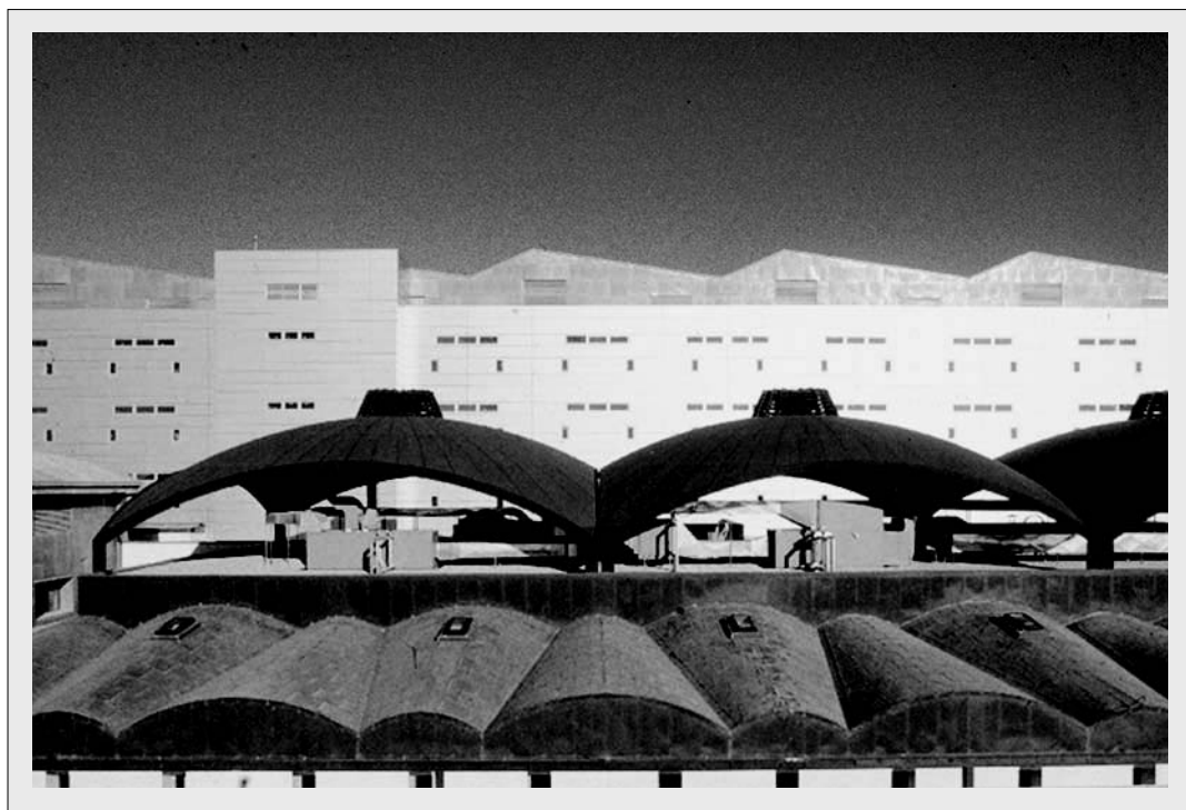
Figura 15.24. Hospital de Manacor (1995), vista parcial de la cubierta del bloque quirúrgico. Ángel Fernández Alba.
